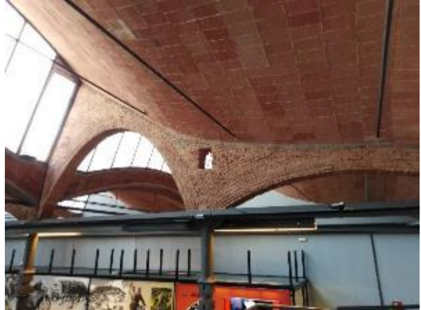
Figure 2.7 - Catalan vaulted roof of the factory building at Terrassa (now Museu de la Ciència i de la Tècnica de Catalunya) designed by Lluís Muncunill i Parellada.
