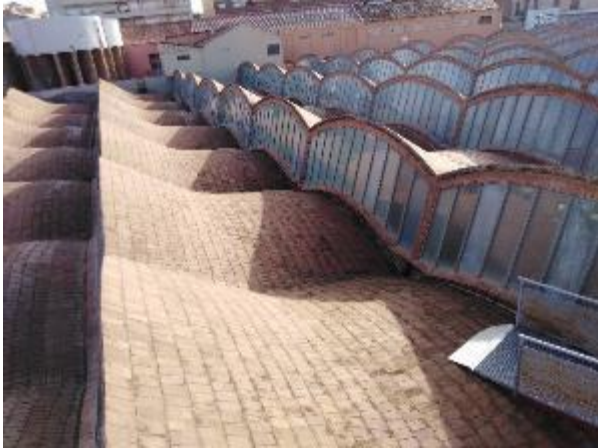
Figure 2.7 - Catalan vaulted roof of the factory building at Terrassa (now Museu de la Ciència i de la Tècnica de Catalunya) designed by Lluís Muncunill i Parellada.
